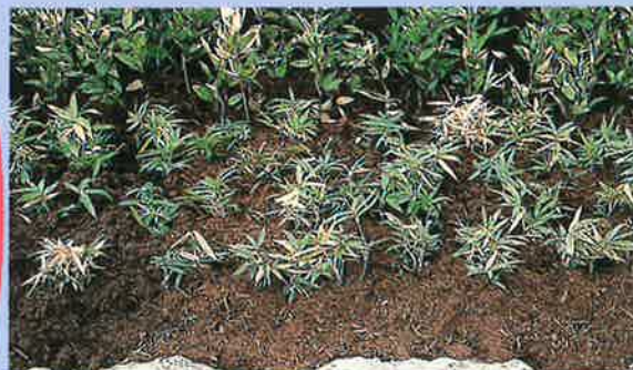
斜面の人工地盤にオカメザサを植栽後、マルチした施工。流亡軽減効果に加え、蒸散軽減、景観向上などの付加価値が得られました。
