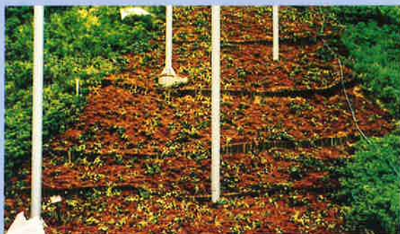
のり面にアイビーを植栽後、マルチした施工。急斜面にもかかわらず土壌流亡もなく、アイビーによる被覆が完成しました。
